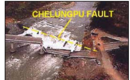
Ruine d'un ouvrage d'art pour non prise en compte de l'aléa local implantation sur une faille décrochante susceptible de jouer en surface. (Séisme de Taiwan, 1999.
